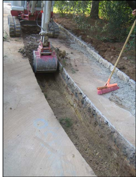
FOTO 6. Inici de la rasa 6
