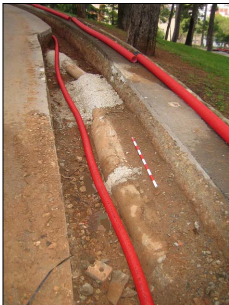
FOTO 3. Vista general de la rasa 3 on s'hi pot apreciar una canalització en desús
