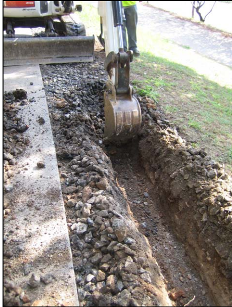
FOTO 1. Inici de la rasa 1
